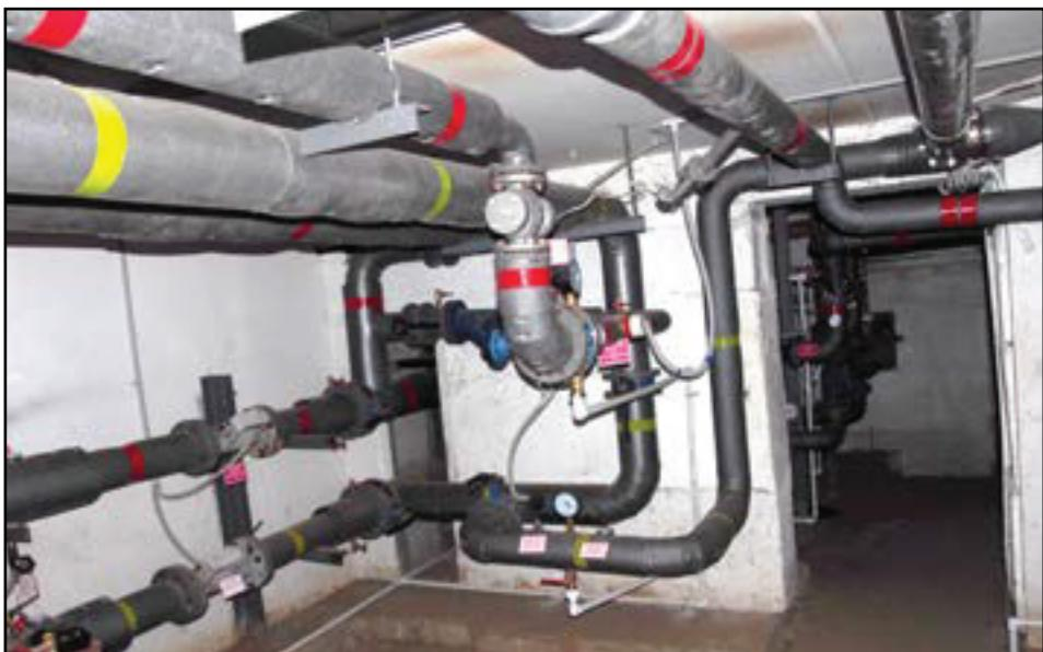
**Рис. 2.** Планшетная компоновка ИТП с теплообменниками ТТАИ.
